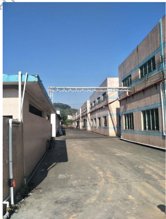
项目北面 郁南万兴机器厂
